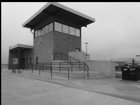
EDIFICIO DE RECEPCIÓN DE CAMIONES CONSTELLATION BRANDS INTERNATIONAL / CERVECERA
