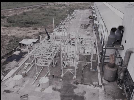
REFINERÍA DE AZÚCAR INGENIO TALA
